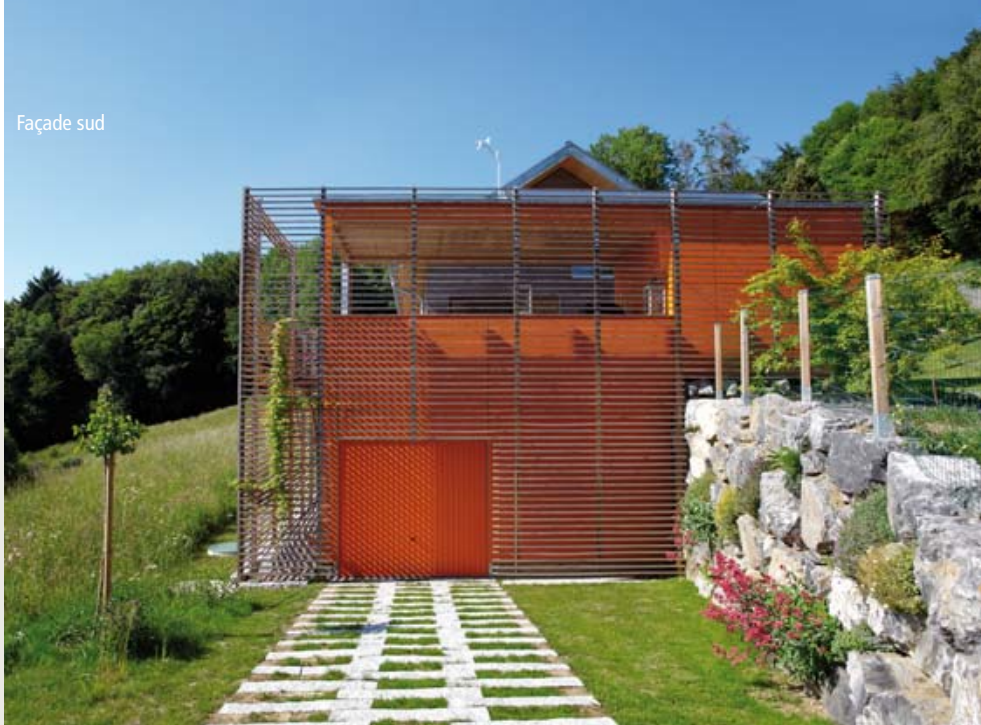
Habillage en Eternit
